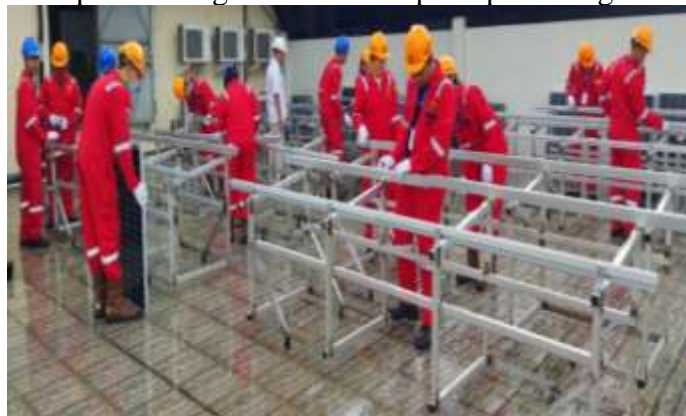
Gambar 3. Gambar Keterlibatan Peserta Pelatihan dalam Melakukan Praktek Pemasangan Konstruksi PLTS
