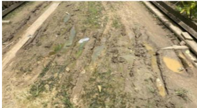
Gambar 1. Kondisi Kerusakan Permukaan Jalan Akibat Kualitas Konstruksi Rendah dan Pengaruh Air di Desa Long Pejeng (Dokumentasi Penelitian, 2026)
