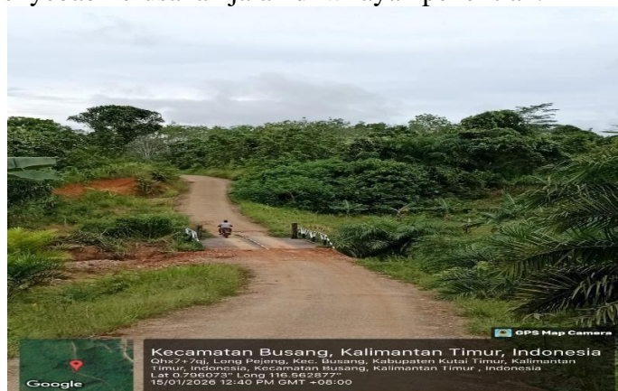
Gambar 3. Kondisi jalan yang menunjukkan interaksi antara factor lingkungan (aliran air dan topografi) dan faktor teknis (konstruksi sederhana) dalam mempercepat kerusakan infrastruktur jalan di Desa Long Pejeng (Dokumentasi Penelitian, 2026)
