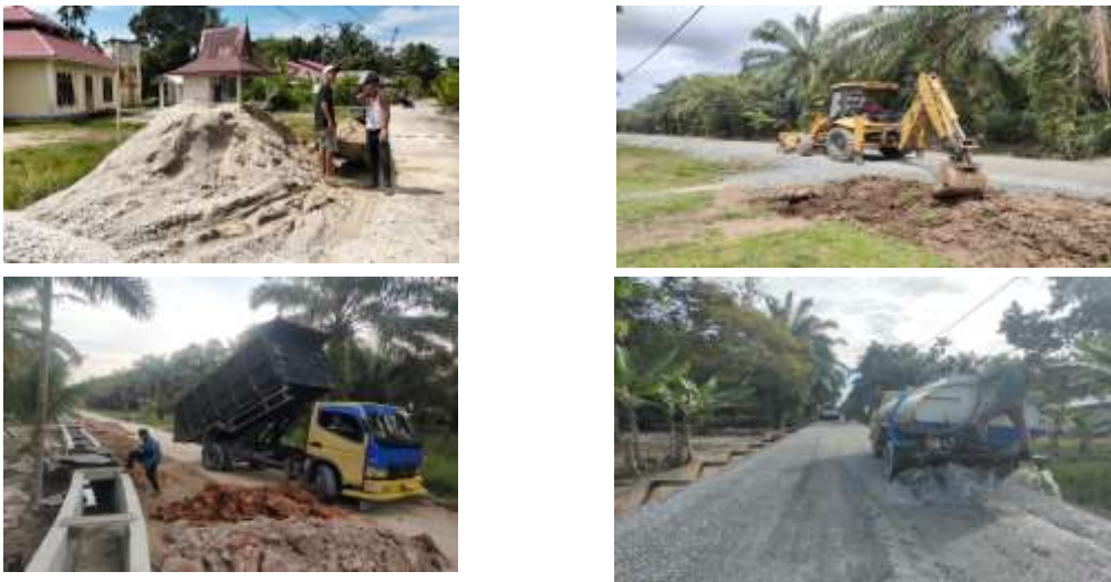
Gambar: Pembangunan Jalan Menuju Kawasan Hutan Mangrove di Desa Hutan Panjang Pada tahun, 2019
