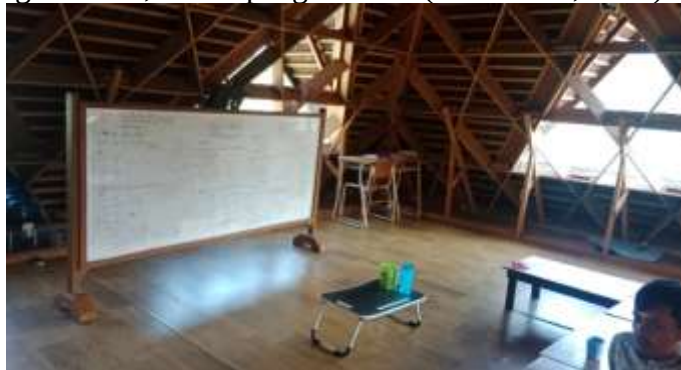
Gambar 1. Ruang Kelas Tenang (Sumber: Olahan Peneliti, 2025)
