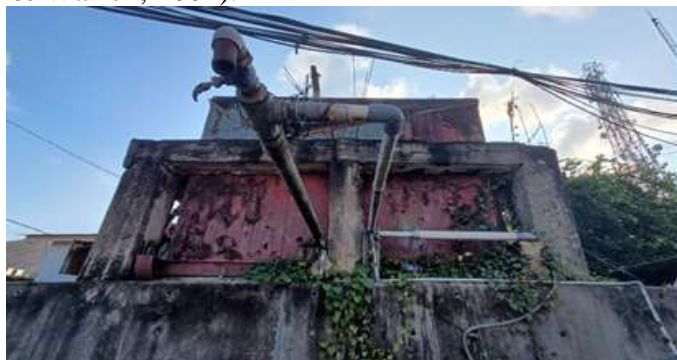
Gambar 3. Bak penampungan air KPC yang sudah tidak beroperasi. (Sumber: Dokumentasi Peneliti)
