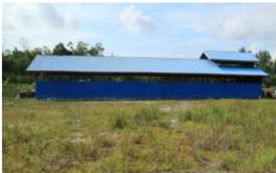
Gambar 3. Gudang Pengolahan Padi
