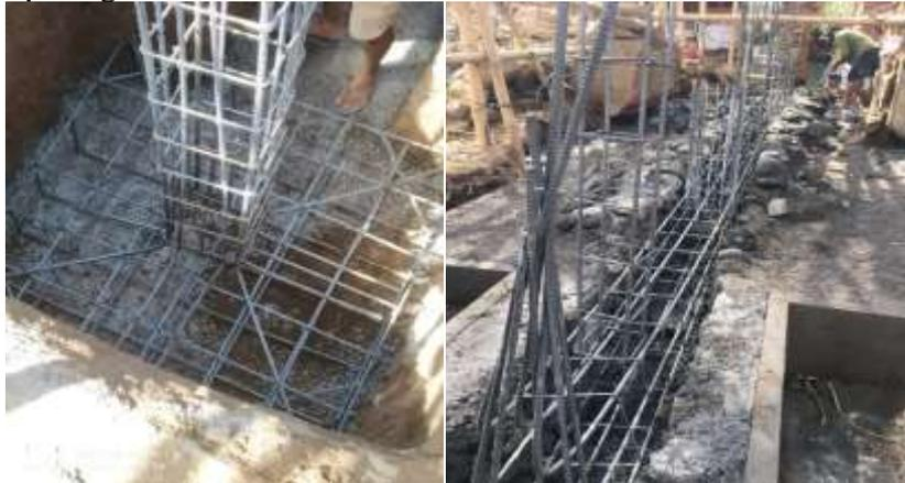
Gambar 13. Pemasangan Pondasi *Footplat* Dan Sloof
