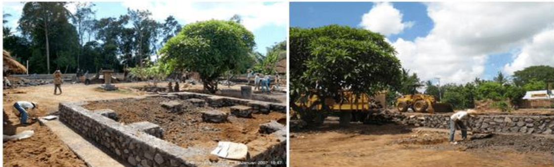
Gambar 11. Pemasangan Pondasi Sumber Foto: Widnyana Sudibya
